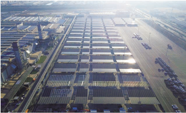
一汽丰田大力加强太阳能光伏建设，截至2021年底，共建成光伏发电容量55兆瓦，年发电量6500万度，绿电占比达10%
